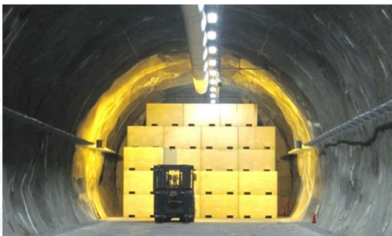
Salle de stockage voûtée du dépôt de Bátaapáti, en Hongrie
